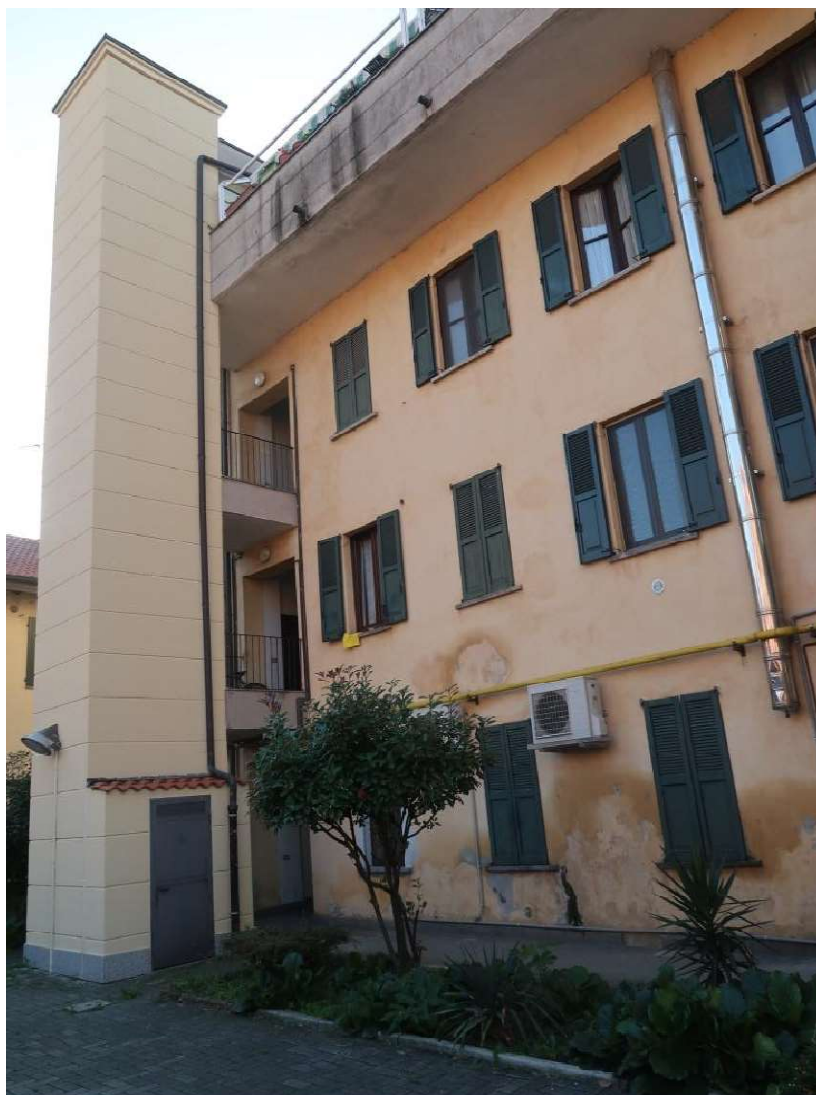
FACCIATA SU CORTILE INTERNO
