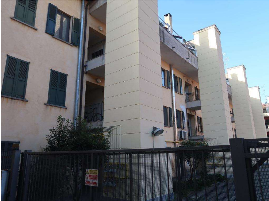
FACCIATA SU CORTILE INTERNO
