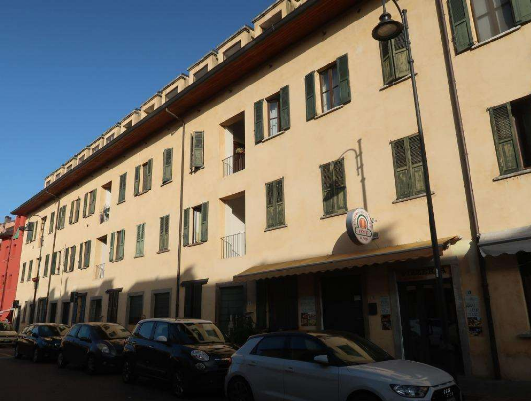
FACCIATA SU VIA VENINO
