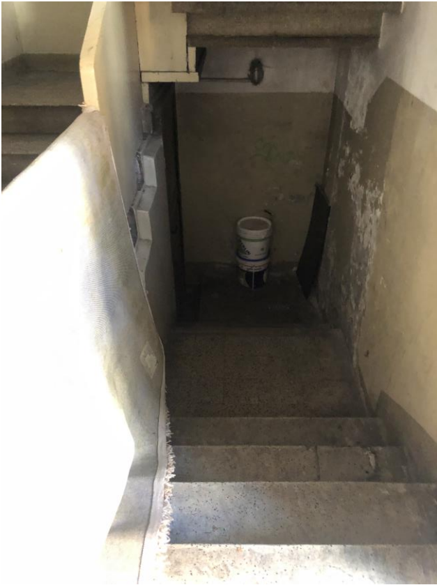
Vista scala per cantine
