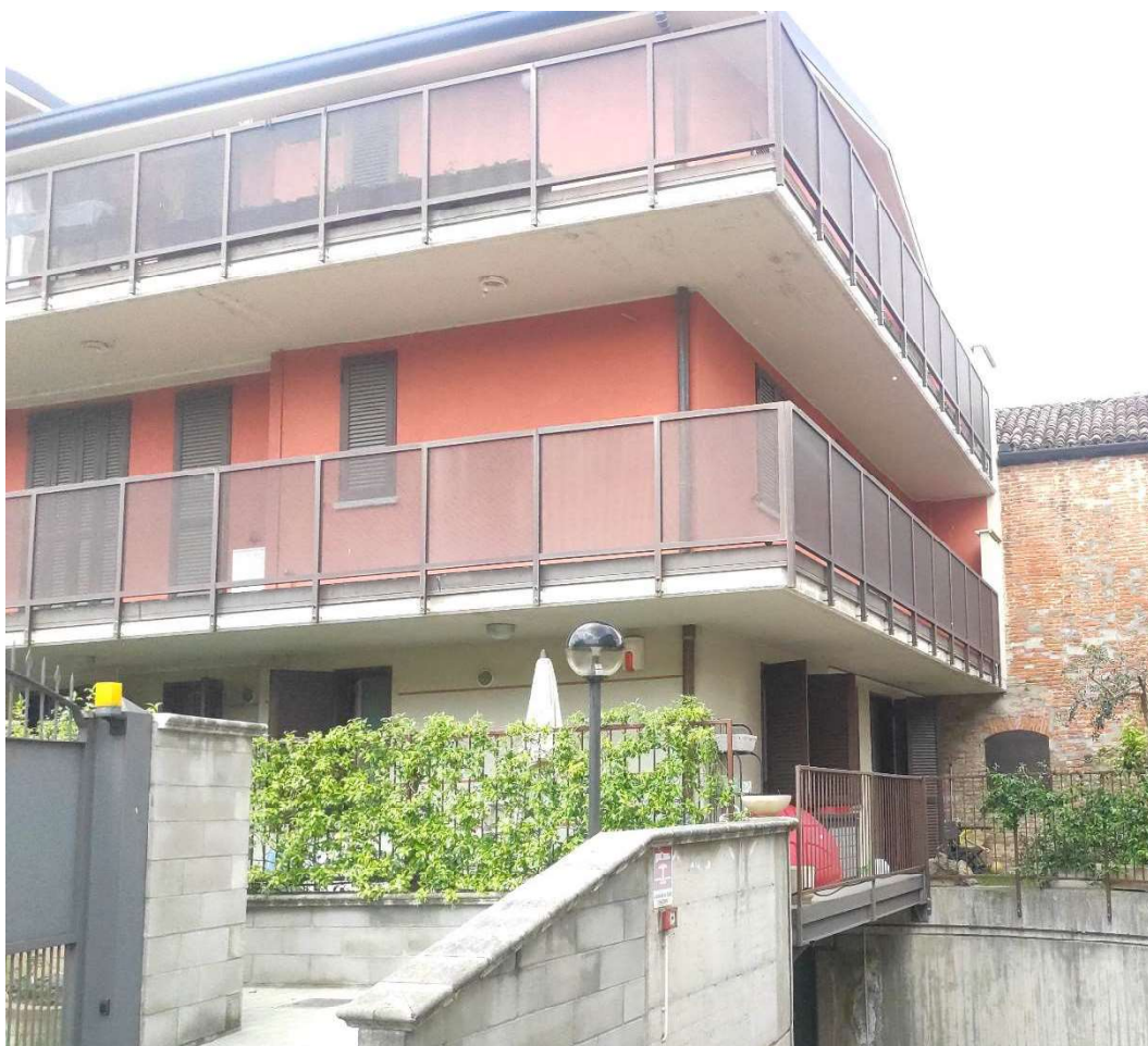
Foto n. 26 – Prospetto del fabbricato
