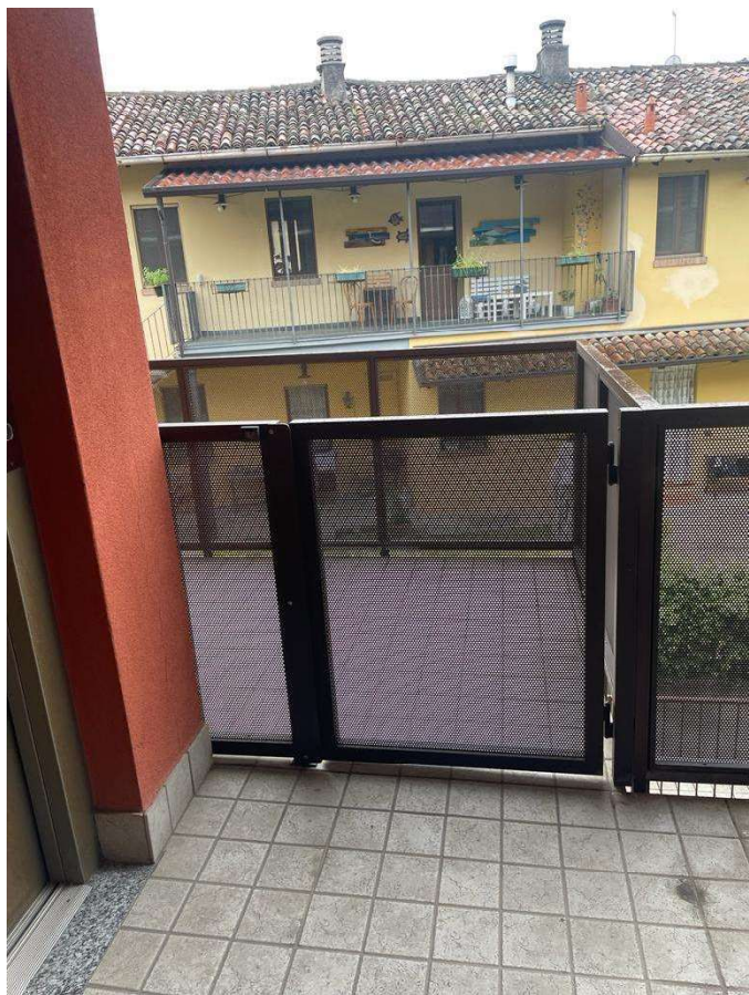
Foto n. 27 – Ingresso al lotto C
