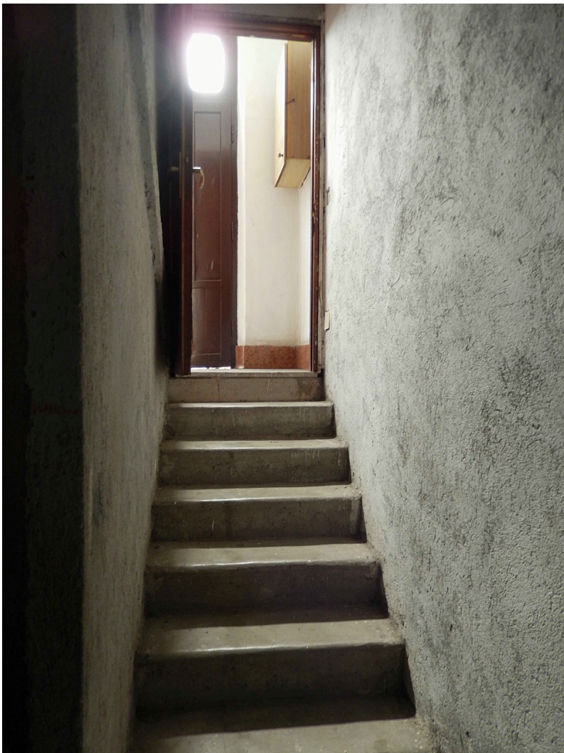
Foto 14 – La scala comune di accesso al piano cantina.
