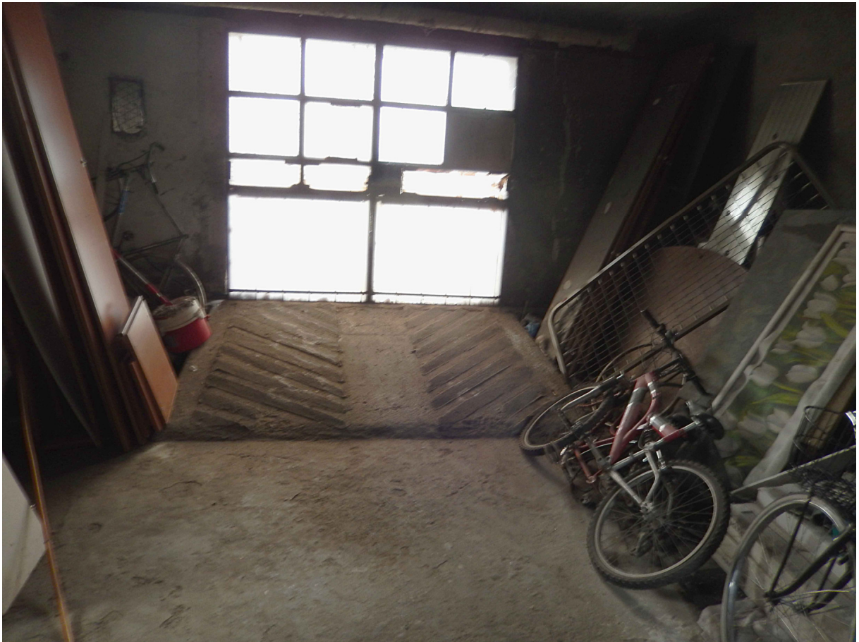
Foto 15 – Vista parziale del locale cantina con rampa carraia lato via XI Febbraio.
