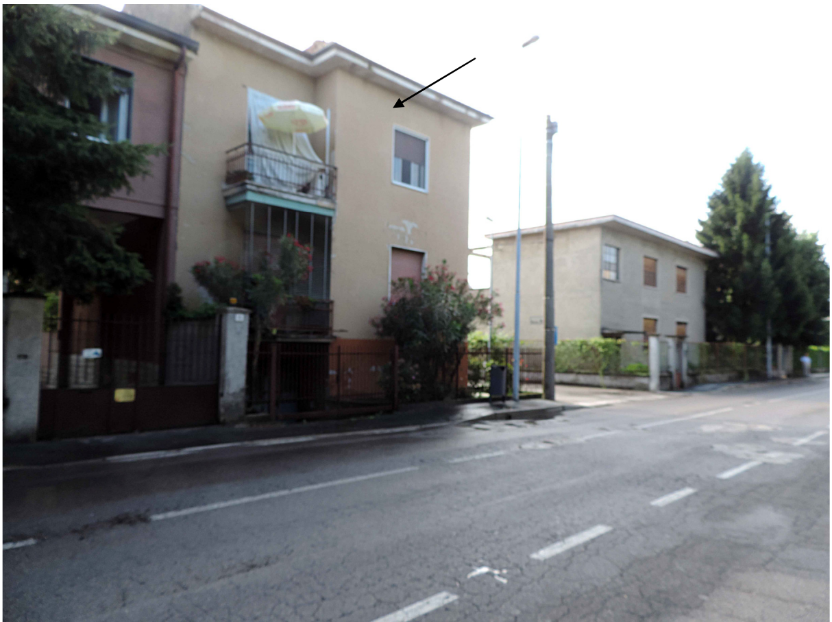
Foto 2 – Il prospetto sulla via XI Febbraio.
