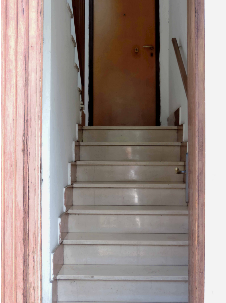
Foto 5 – Il vano scala Comune. Vista parziale.
