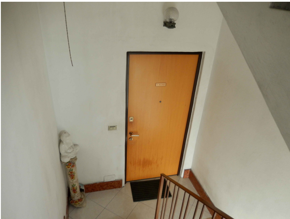
Foto 6 – Il pianerottolo al primo piano con la porta d'ingresso al bene in esame.
