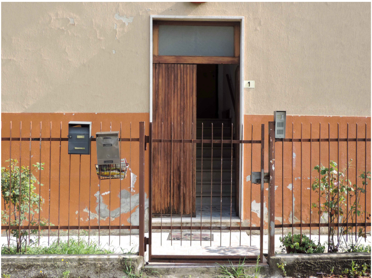
Foto 4 – Il cancelletto esterno pedonale ed il portone d'ingresso all'edificio.
