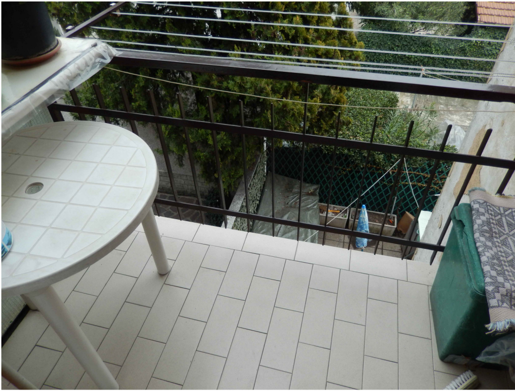
Foto 9 – Il balcone della cucina.
