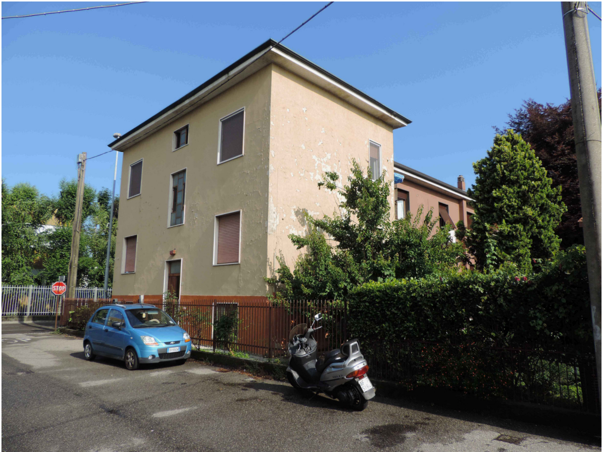
Foto 3 – Vista dalla via Monte Rosa (da sud est).
