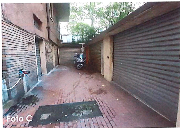
Foto C- Veduta ingressi al magazzino;
