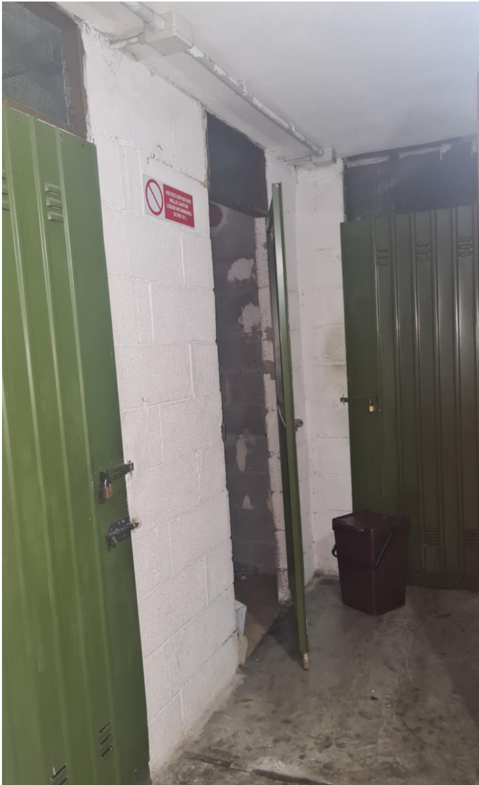
FOTO 14: BOLLATE, VIA RAFFAELLO SANZIO 18, Cantina
