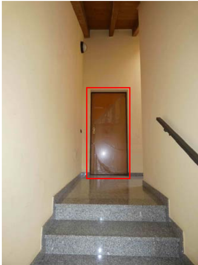
Foto 7. Porta d'accesso all'appartamento
