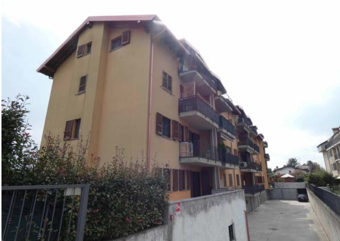
Foto 5. Prospetto lato box complesso condominiale
