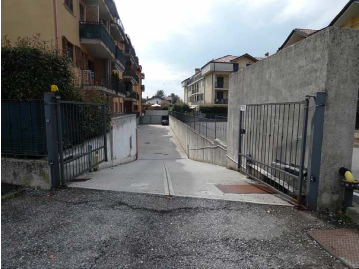
Foto 3. Ingresso carraio complesso condominiale
