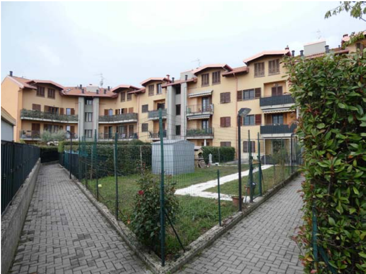
Foto 4. Prospetto principale complesso condominiale
