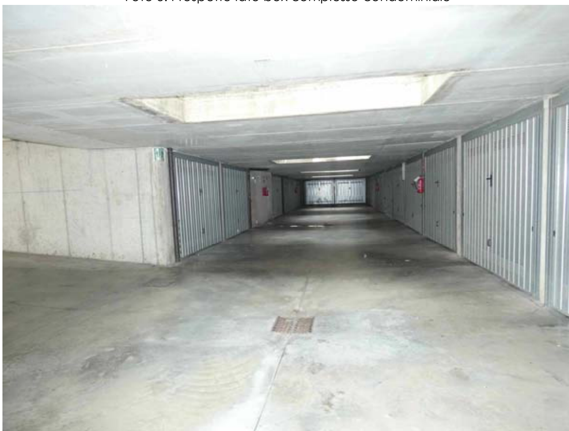
Foto 6. Corsello coperto box
