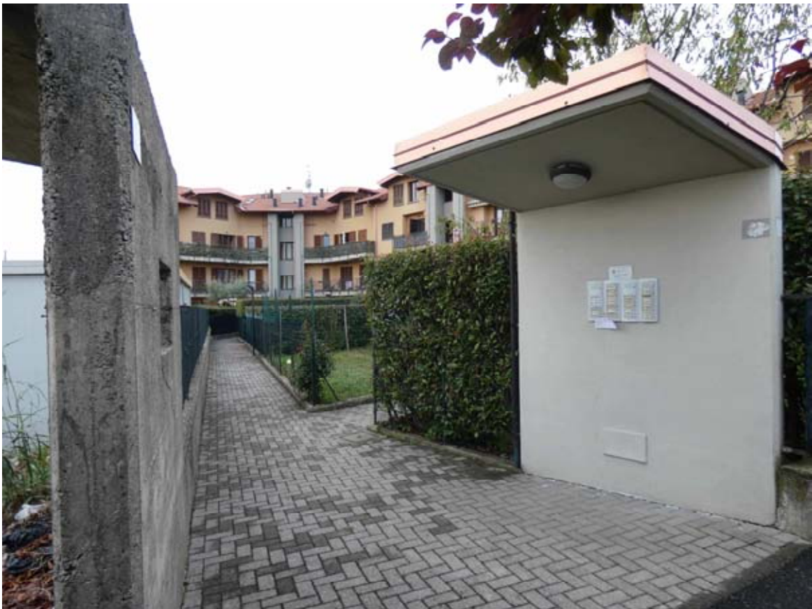
Foto 2. Ingresso pedonale complesso condominiale
