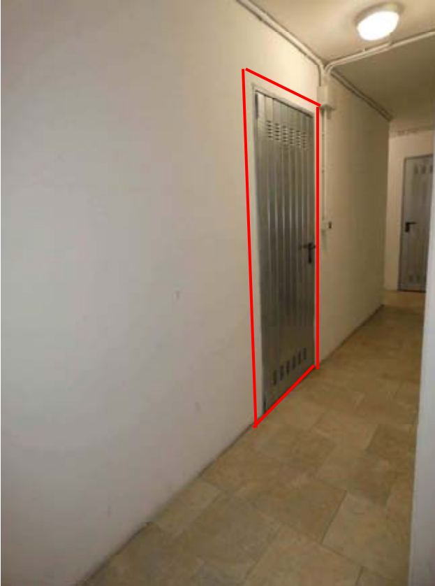
Foto 13. Porta d'accesso alla cantina
