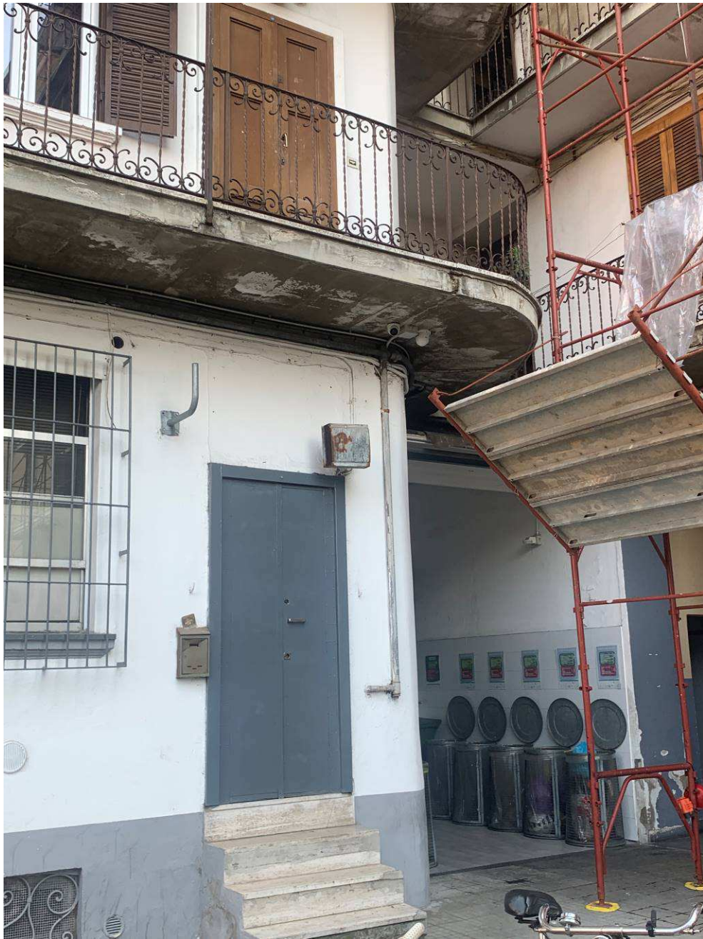
Fotografia n. 8 – Vista della facciata secondaria del Condominio di Via Marco Aurelio, 39 Milano, del locale pattumiera, con l'accesso a destra al corpo scale, dove al piano quarto si trova l'immobile oggetto della procedura
