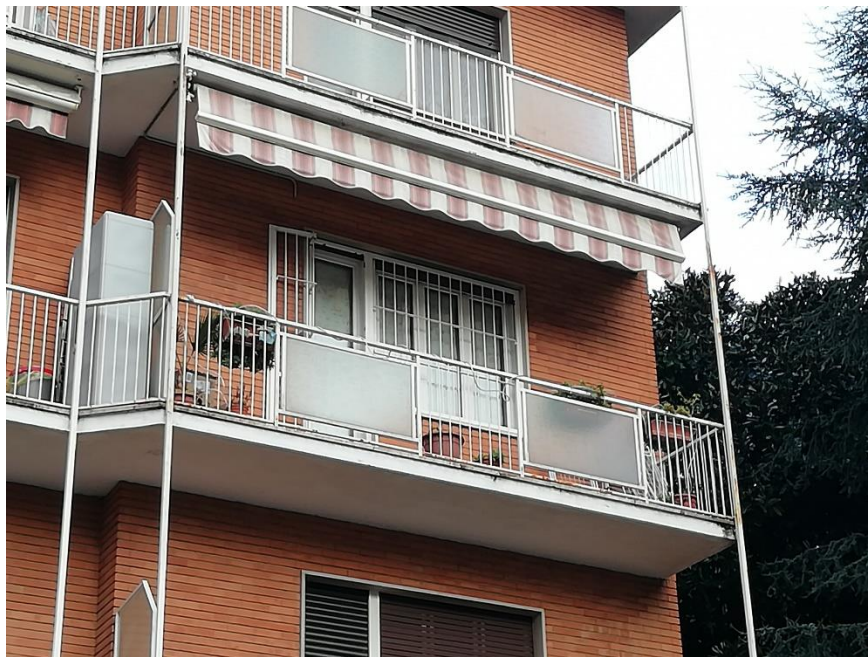
Foto n 32 area esterna su strada
