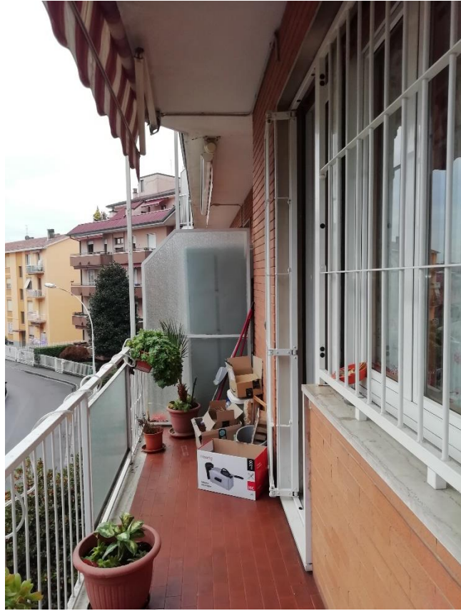
Foto n 27 balconi con grate metalliche
