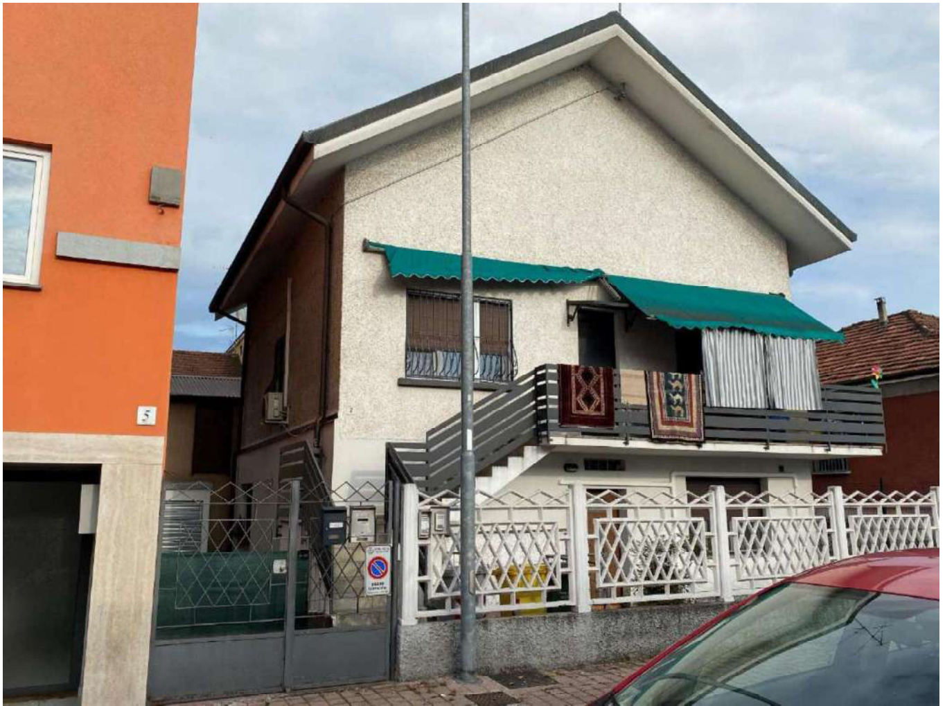
Edificio di Via Cremona 7
