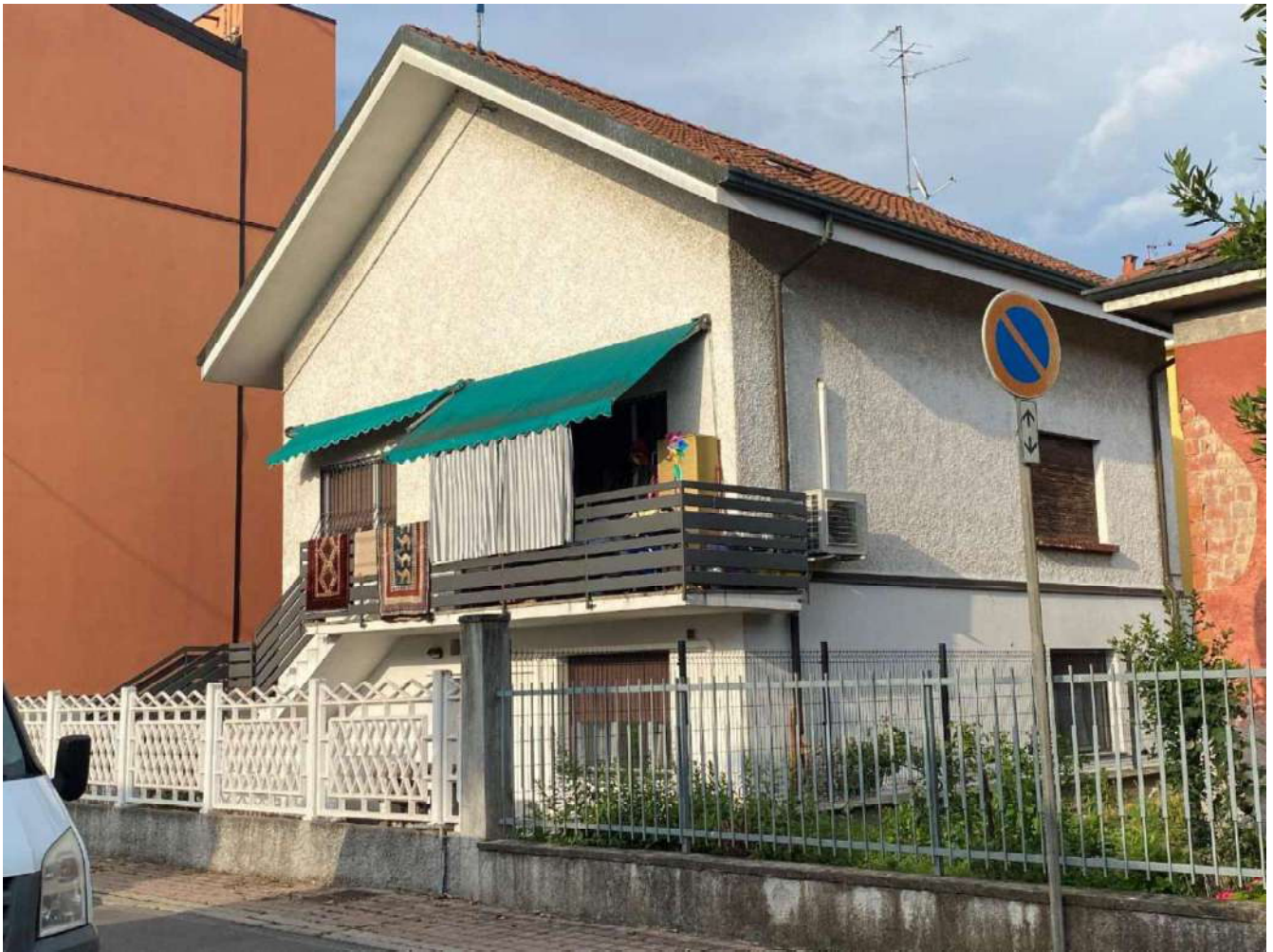
Edificio di Via Cremona 7
