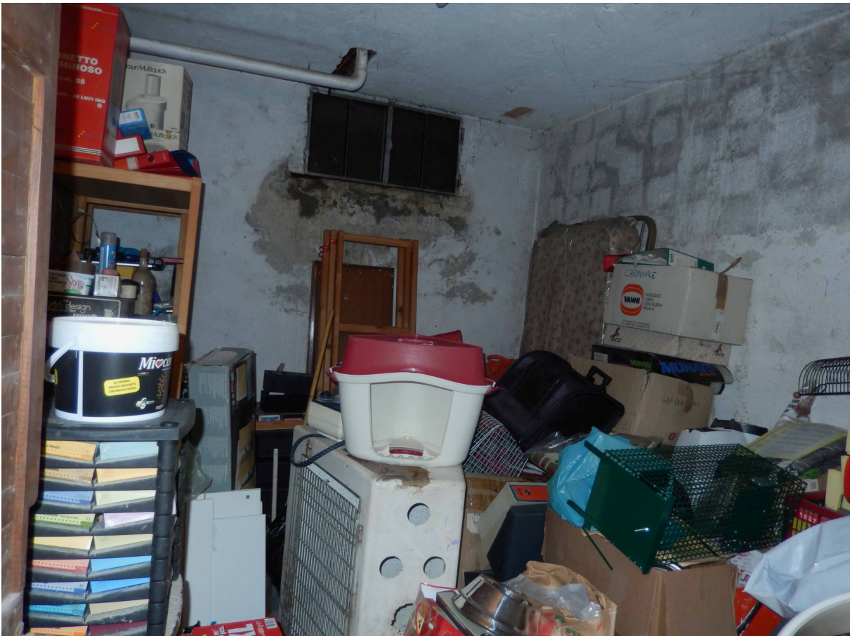
Foto 16 – Vista d'insieme dell'interno della cantina.
