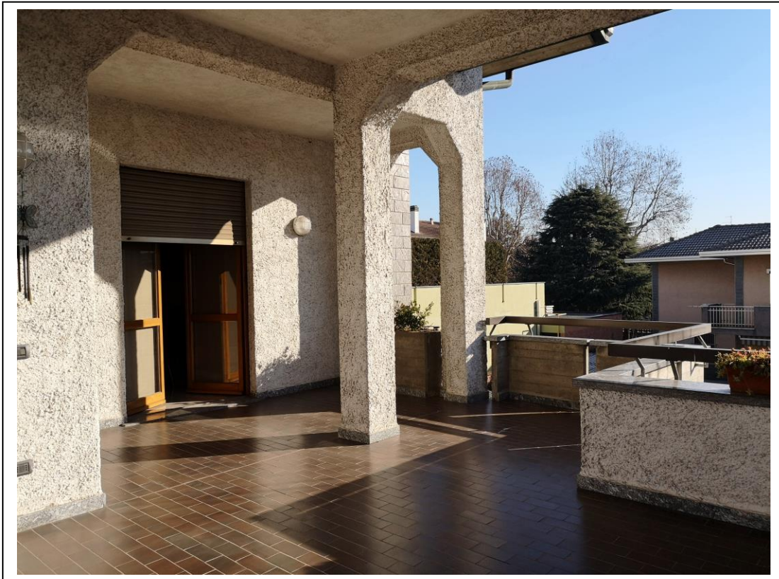
Fotografia n°11 – Vista del terrazzo e dell'accesso dal locale cucina.
