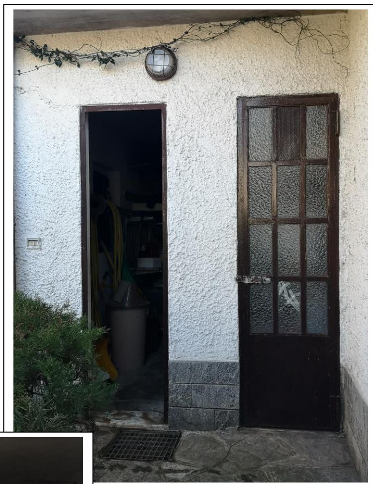
Fotografia n°17 – Vista della porta d'ingresso al locale deposito Sub.2.
