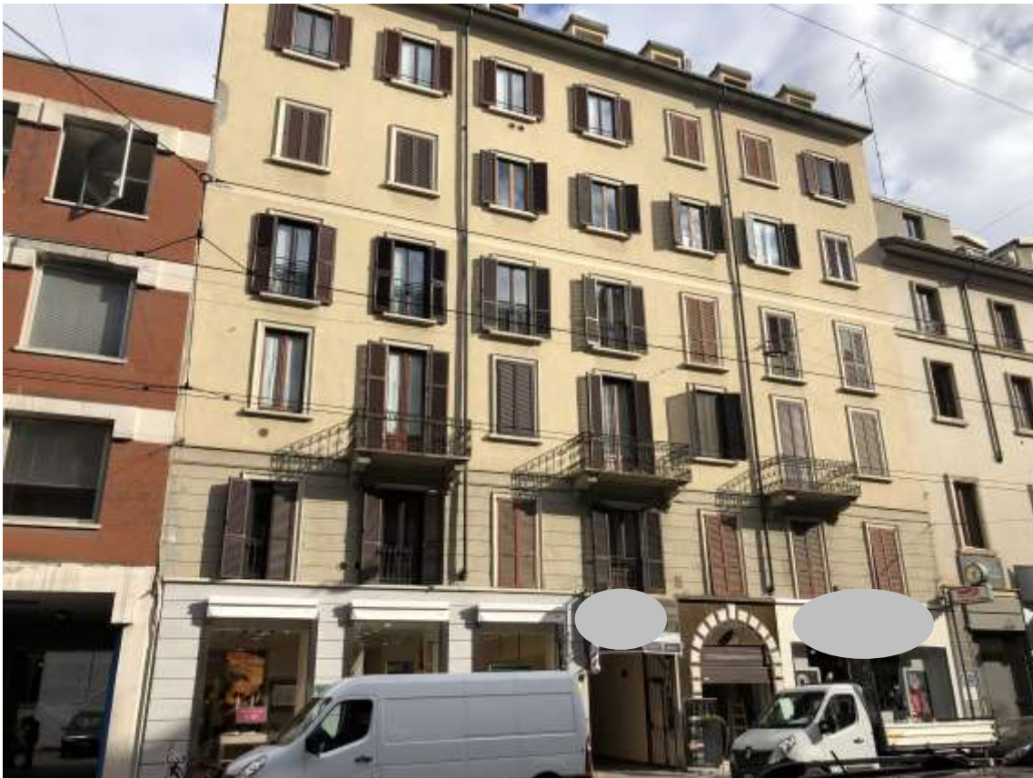
Vista del fabbricato da Corso Vercelli
