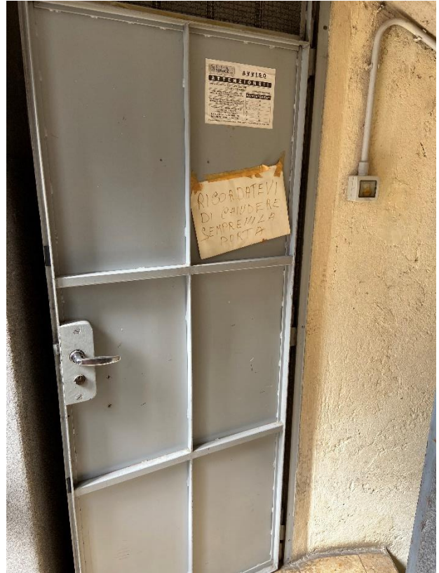
Vista porta accesso alle cantine
