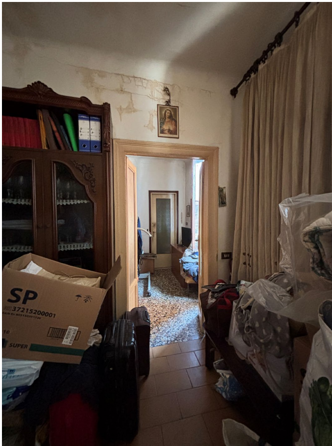
Immagine 15. Il soggiorno è passante e consente di accedere ad un locale analogo utilizzato come camera da letto. Anche sul muro di spina si notano gli effetti dei fenomeni infiltrativi.
