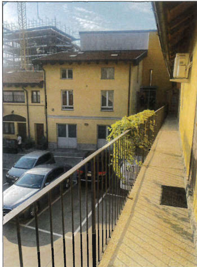
BALLATOIO DI ACCESSO ALL'UNITA' IMMOBILIARE
