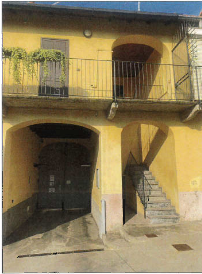
CORPO SCALE DI ACCESSO AL PIANO PRIMO
