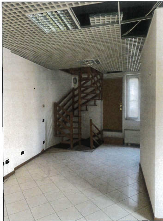
SCALA DI ACCESSO AL PIANO SECONDO SOTTOTETTOE SOTTOSTANTE PIANO TERRNO DI ALTRA PROPRIETA'
