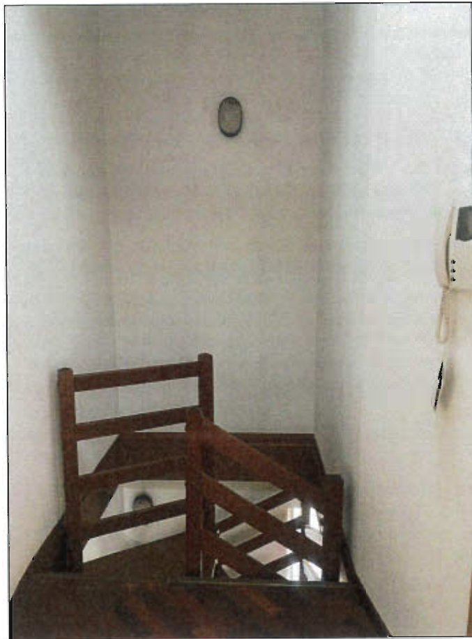
SCALA DI ACCESSO AL PIANO SECONDO SOTTOTETTO
