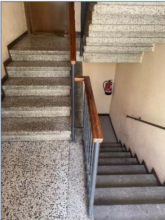
Foto 11 - vano scala comune
