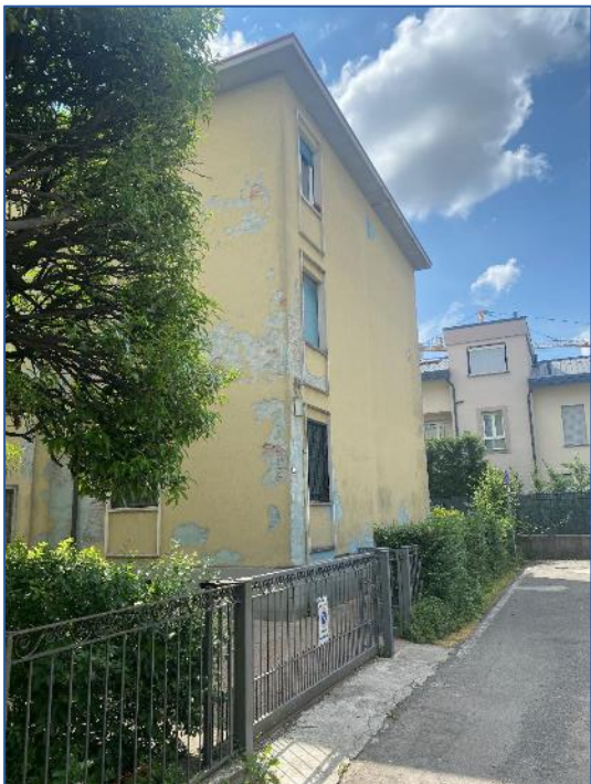
Foto 1 - immobile di via Sant'Orsola n. 5
