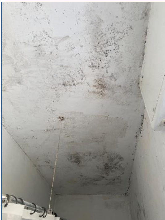
Foto 39 - dettaglio plafone bagno
