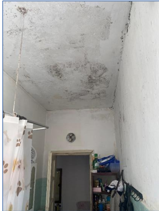
Foto 38 - dettaglio plafone bagno
