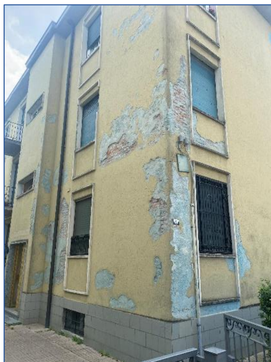
Foto 4 - immobile di via Sant'Orsola n. 5
