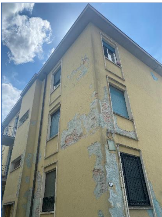
Foto 3 - immobile di via Sant'Orsola n. 5
