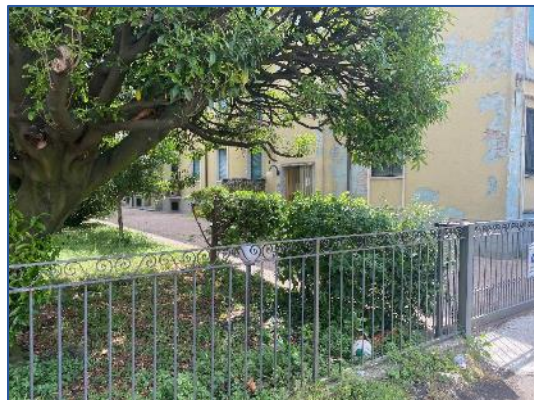
Foto 2 - immobile di via Sant'Orsola n. 5
