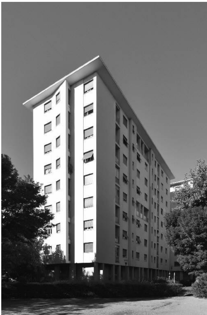
Immagine 1. Foto del fabbricato.
