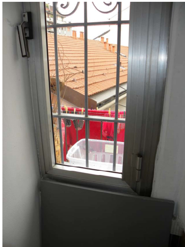
Particolare serramenti ed inferiate
