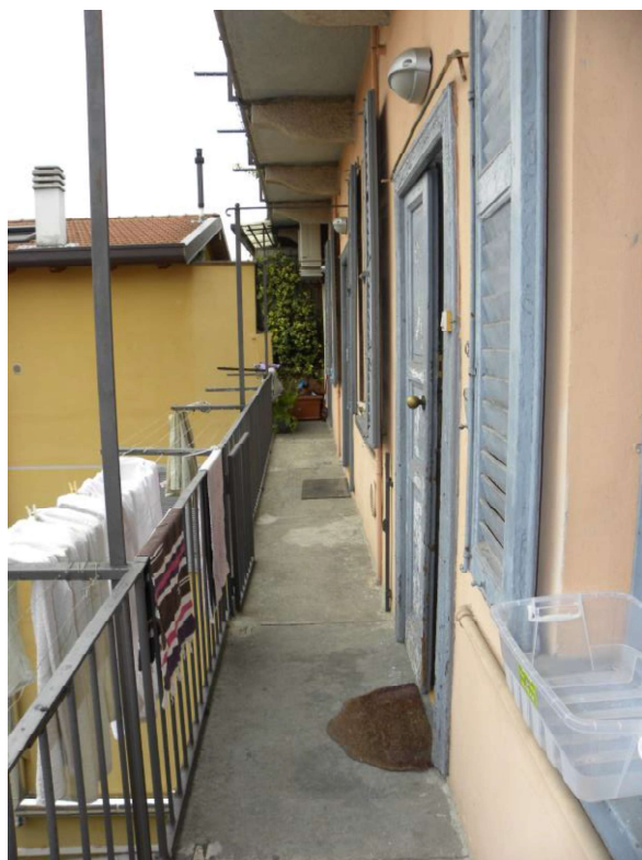
Ballatoio – parte comune
