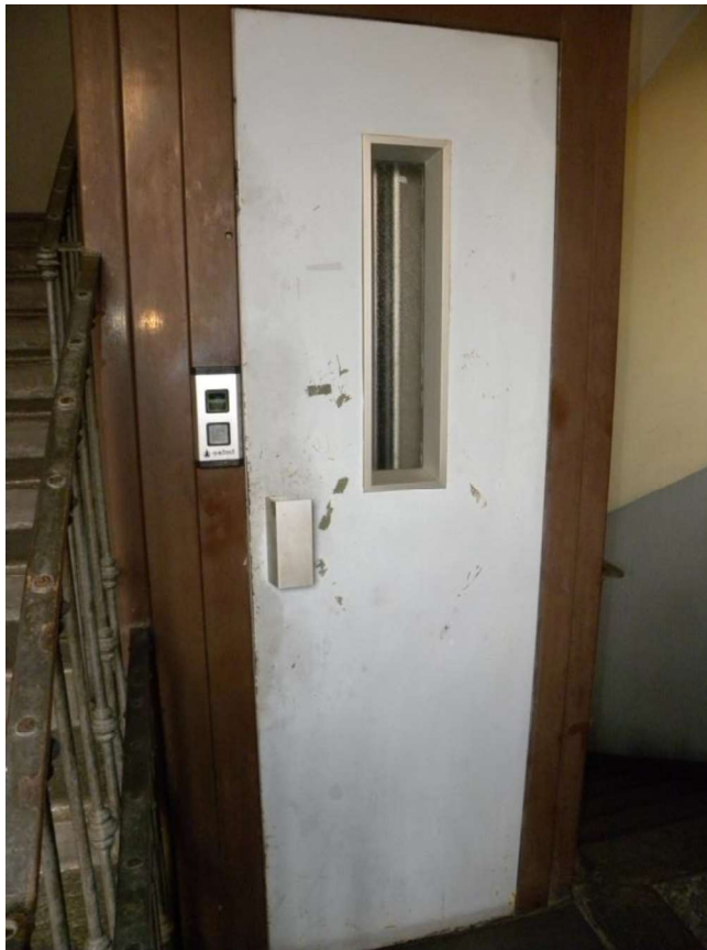
Ascensore dello stabile
