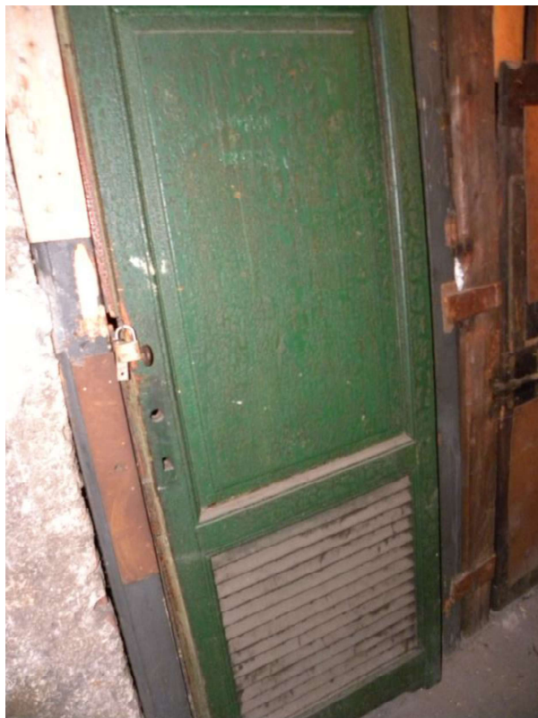
Porta di accesso al solaio
