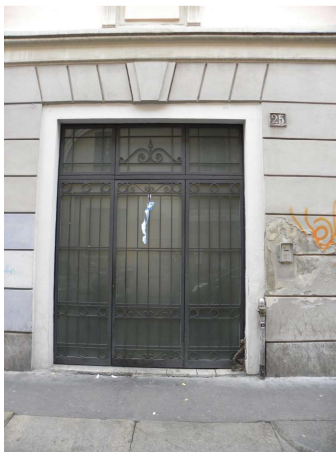
Accesso al fabbricato da strada
