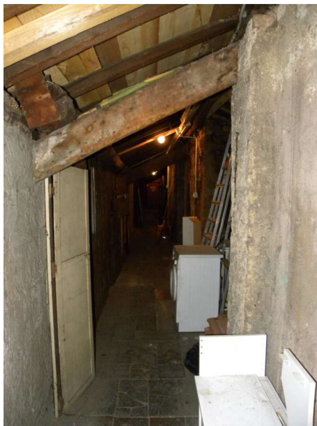
Piano sottotetto corridoio solai – parti comuni
