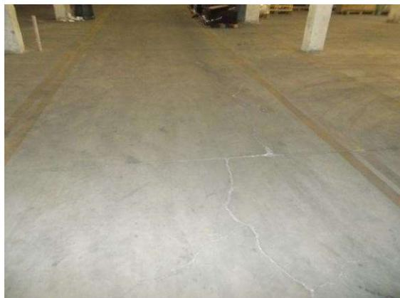
48. Pavimentazione in battuto di cemento
