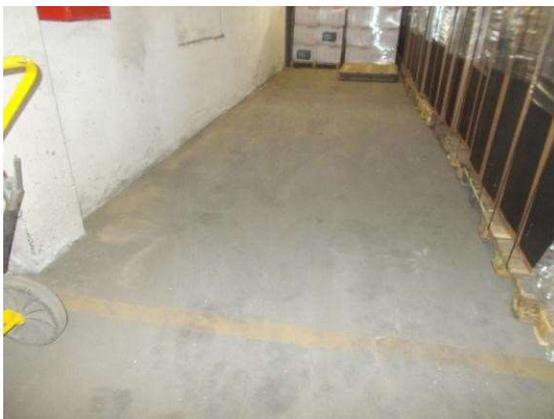
47. Pavimentazione in battuto di cemento
