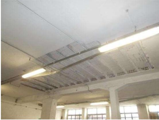
43. Dettaglio del soffitto in latero cemento
