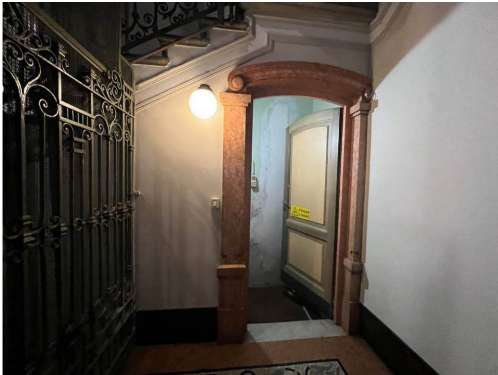
Fotografia n. 43 – Vista dell'ingresso ai locali cantina al piano seminterrato
