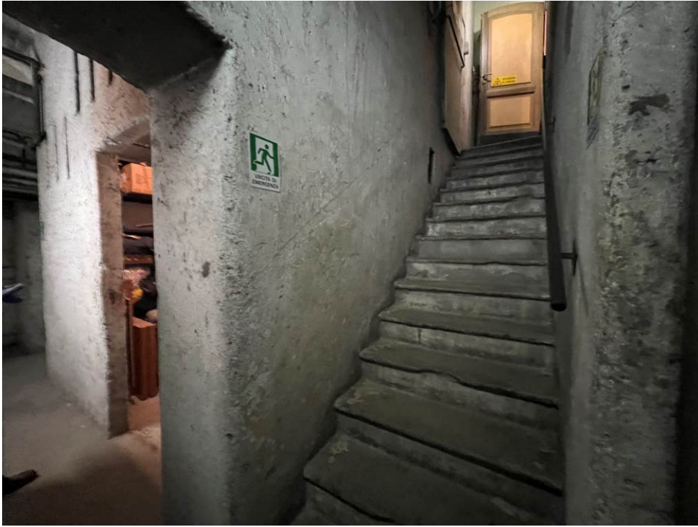
Fotografia n. 44 – Vista della scala che conduce ai locali cantina, con l'accesso al vano cantina oggetto della procedura
