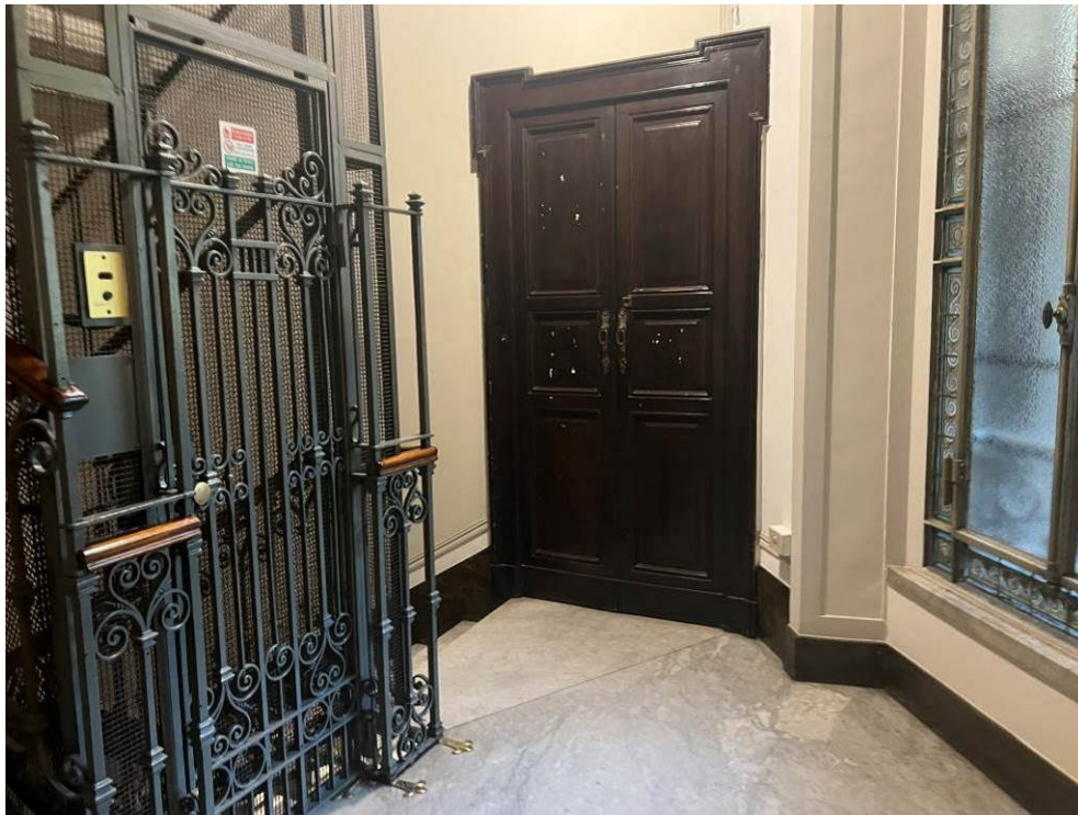
Fotografia n. 12 – Vista del pianerottolo al piano primo con la doppia porta di ingresso all'appartamento oggetto della procedura (sul locale cucina adibito a lavanderia): la porta esterna, con apertura a doppio battente, si presenta chiusa (assenza di chiavi – smarrite, come da dichiarazione del debitore), mentre la porta interna non è visibile, poiché coperta da un mobile fisso, ma il debitore a tale riguardo dichiarava che la stessa non è presente, in quanto l'apertura è stata murata
