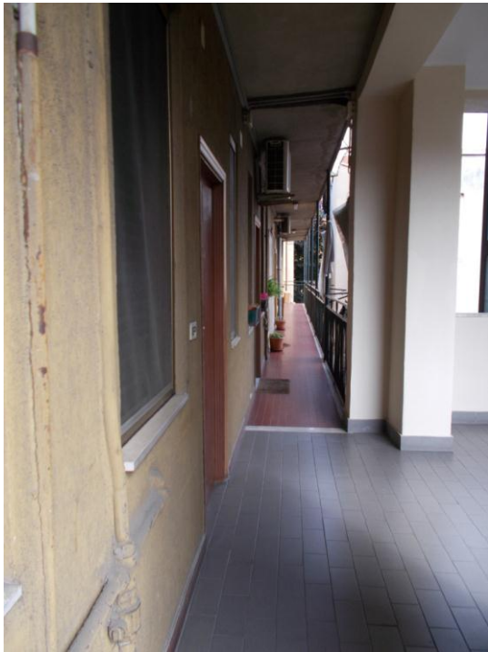
7. Ballatoio comune (verso le scale)
