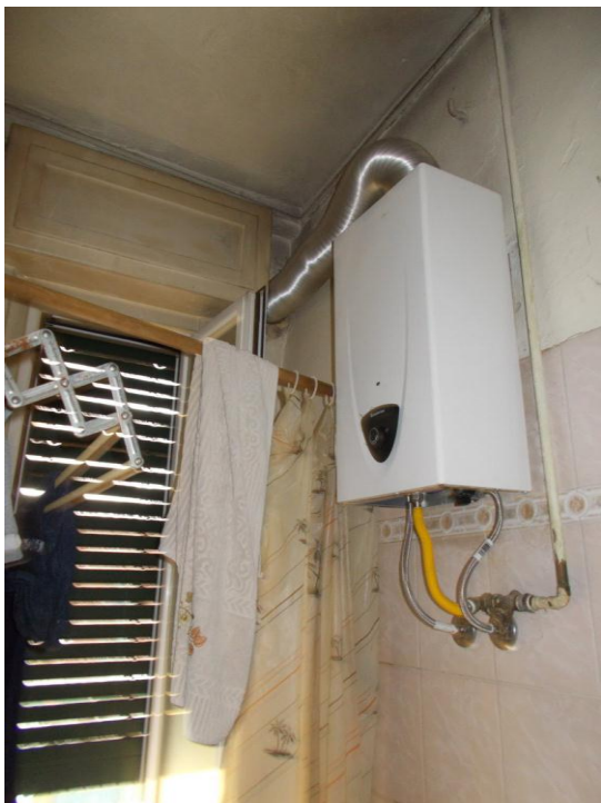
21. Bagno (boiler elettrico)
