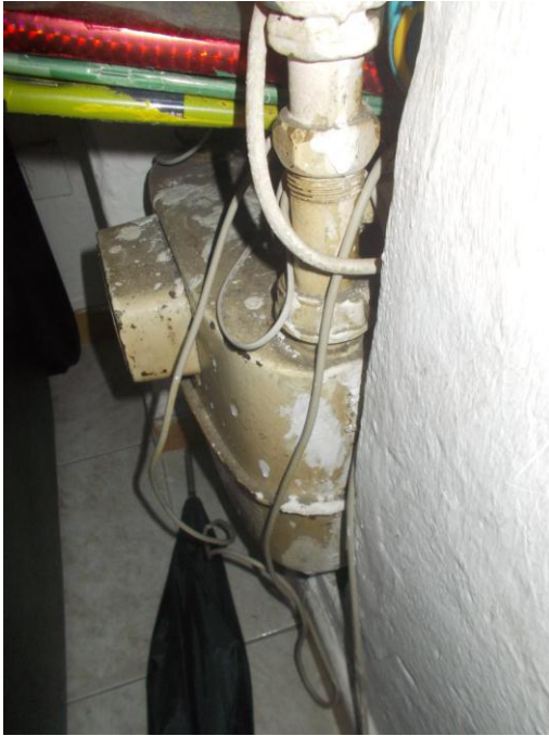
33. Contatore del gas interno all'appartamento
