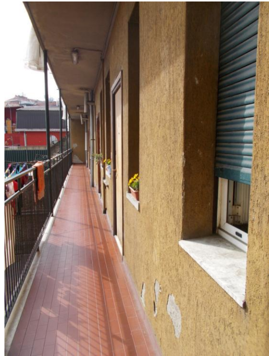
8. Ballatoio comune (verso l'ingresso all'immobile)
