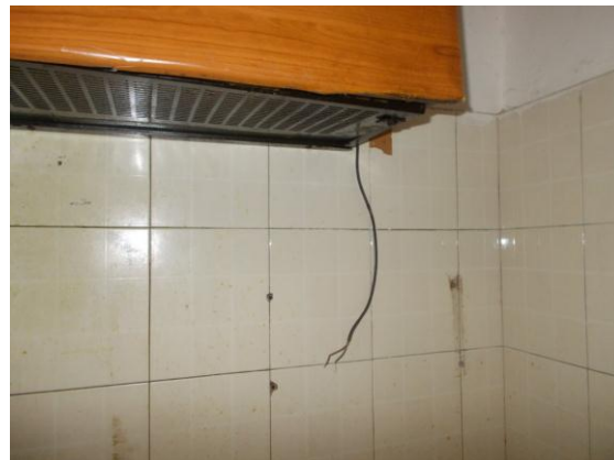
30. Filo elettrico scoperto
