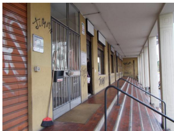
2. Portico di ingresso al fabbricato
