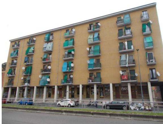
1. Panoramica del fabbricato
