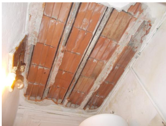
25. Soffitto del bagno
