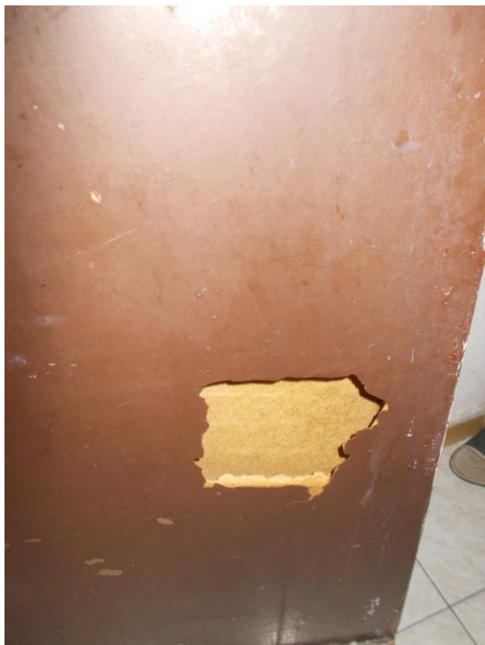
9. Portoncino di ingresso all'immobile
