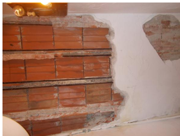
26. Soffitto del bagno
