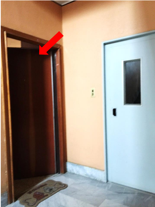
Vista porta ingresso
