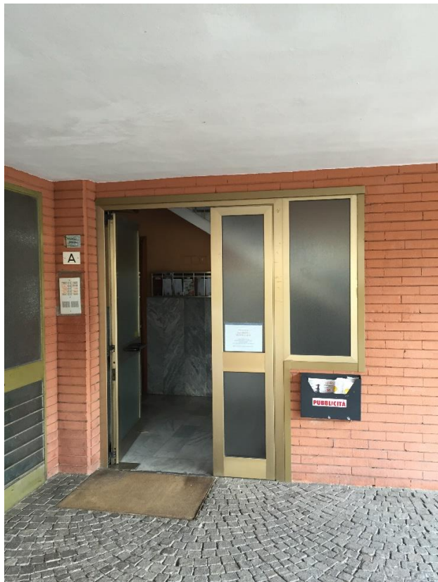
Vista portone di ingresso scala A
