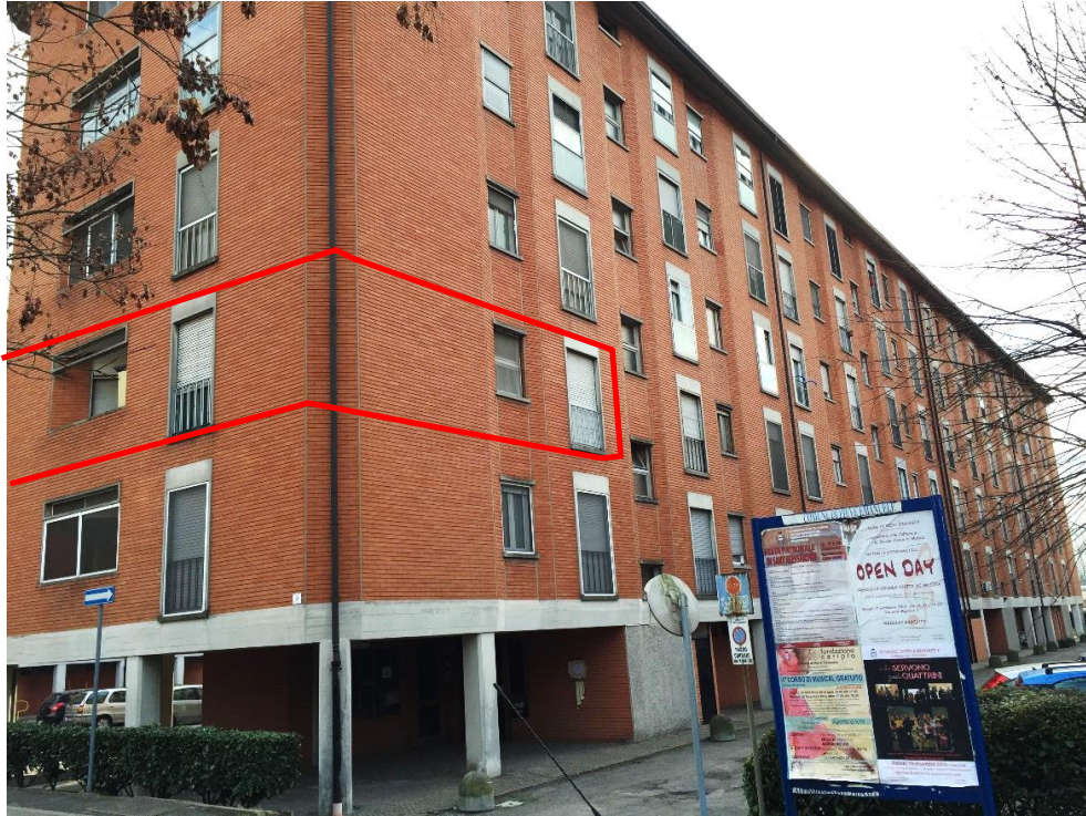
Vista del fabbricato da Via Verdi e ingresso a scala A
