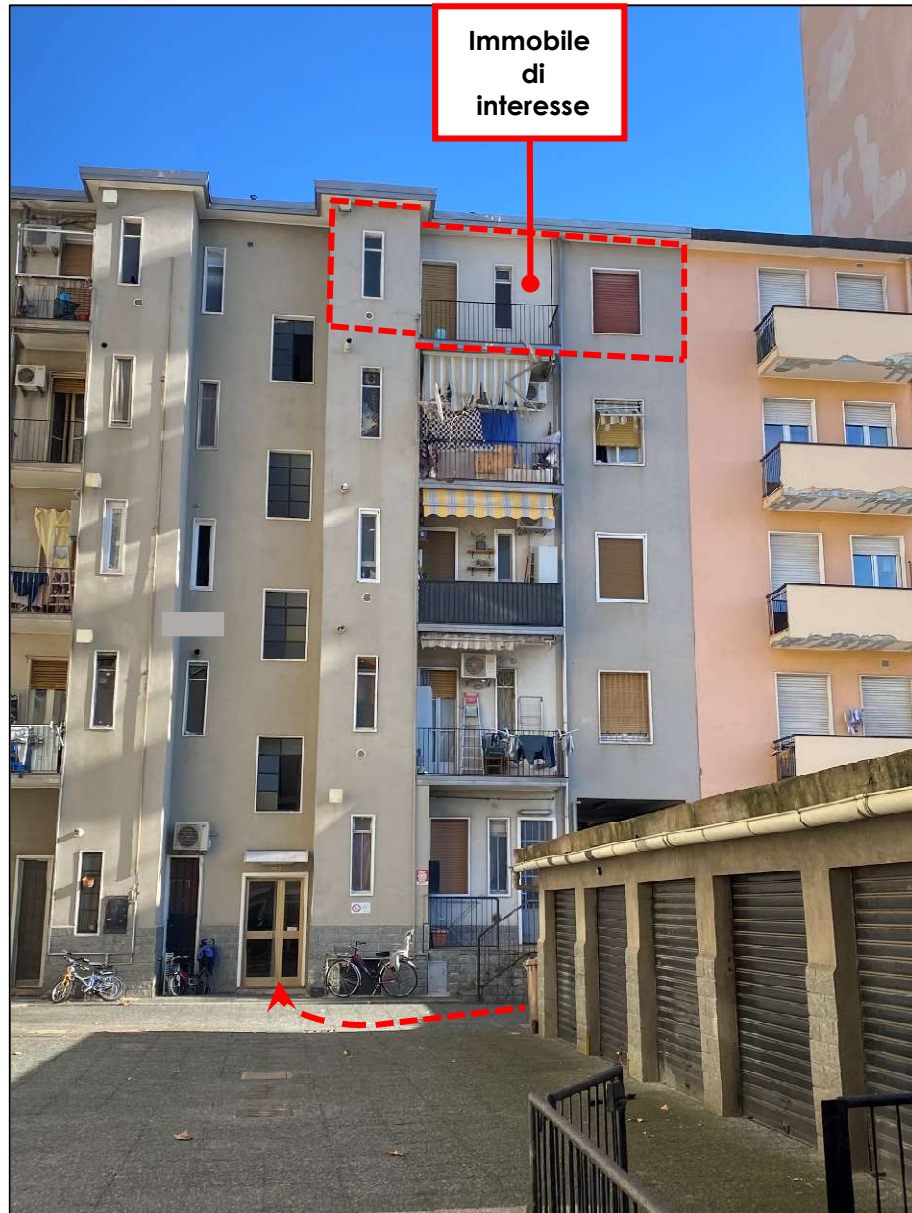
Foto n°5 – Prospetto dell'edificio sul cortile interno - Scala "E"
