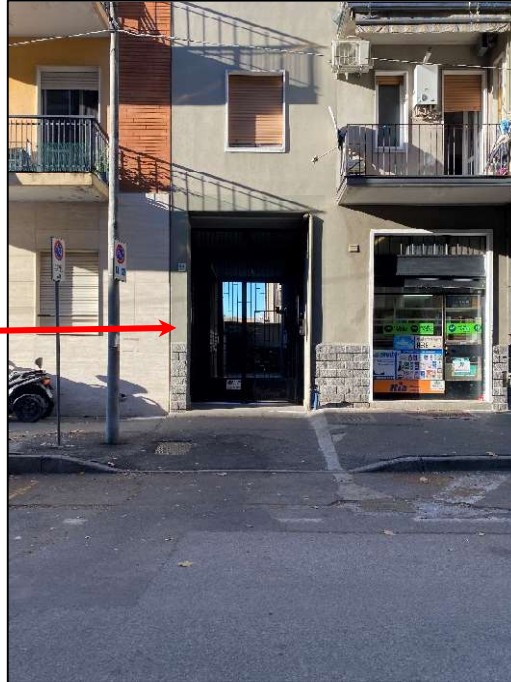
Foto n°3 – Vista dell'accesso pedonale e carrabile
