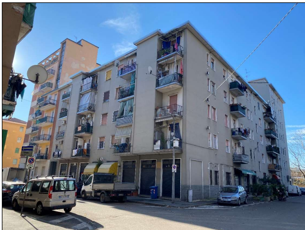
Foto n°2 – Vista prospettica dell'edificio dalla Via Gadames
