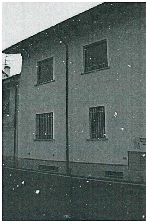
Foto 61 – Facciata su strada
