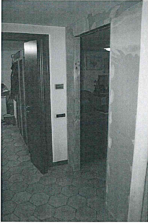
Foto 40 – Disimpegno piano cantina
