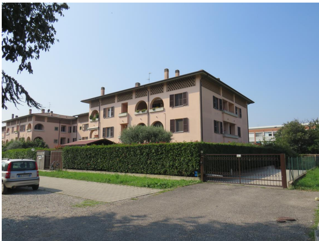
FACCIATA SU VIA APPIANI
