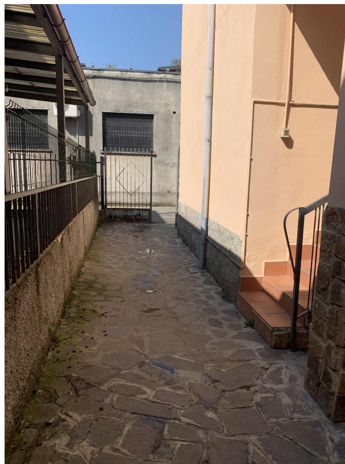
cortile interno accesso all'autorimessa
