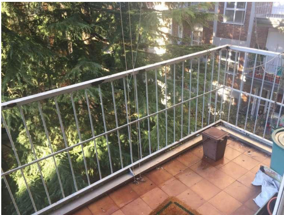
Foto n.10 – balcone lato cucina
