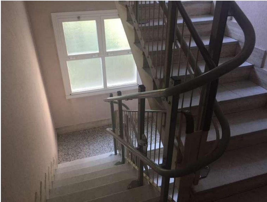
Foto n.3 – vano scala condominiale
