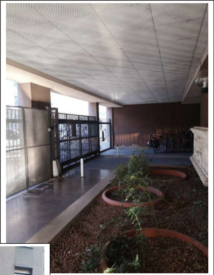
Corpo 2: Box auto pertinenziale posto al piano interrato (sub.57)
