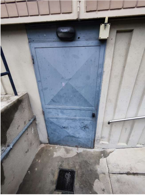
Foto n. 15 – Accesso ai locali cantina
