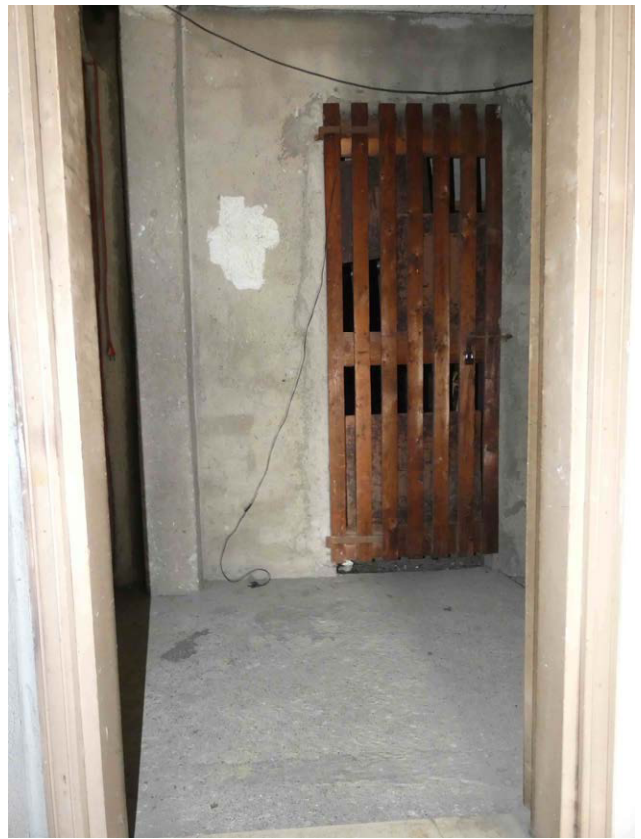
Foto 8. Porta d'accesso al solaio
