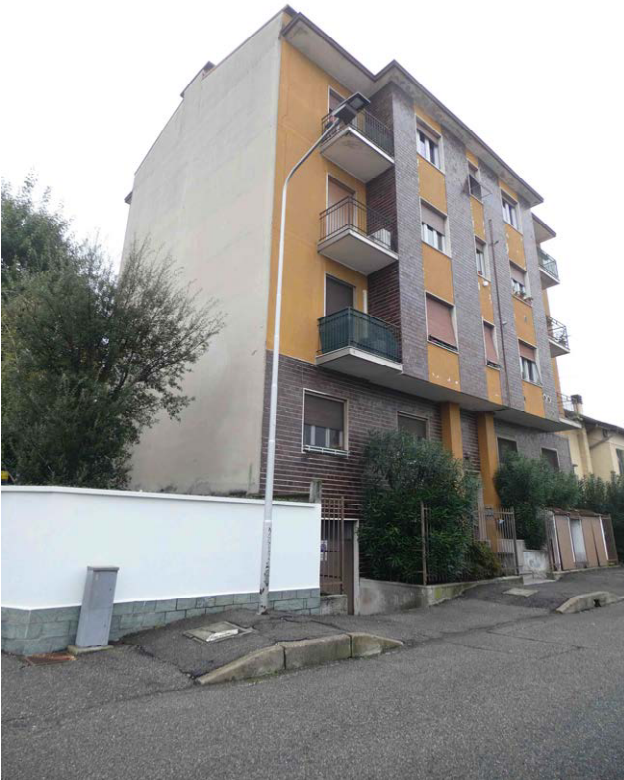
Foto 1. Prospetto su Via A. Toscanini
