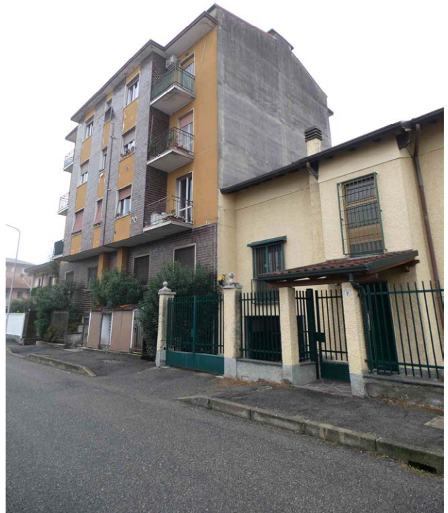
Foto 2. Prospetto su Via A. Toscanini
