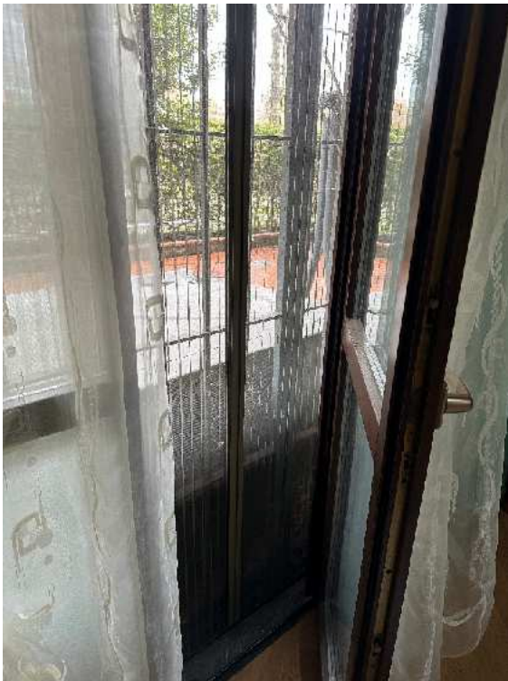
9. Dettaglio del serramento con accesso al giardino esterno.
