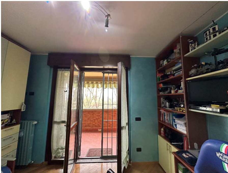
15. Dettaglio del serramento verso la loggia.
