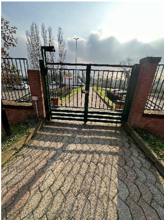
3. Dettaglio del cancelletto pedonale.
