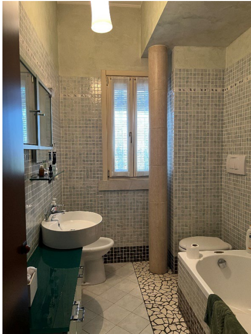
Immagini 15 e 16. I bagni, entrambi aerati e illuminati naturalmente. Il pilastro a sezione circolare è stato aggiunto recentemente per la necessità di un rinforzo strutturale.
