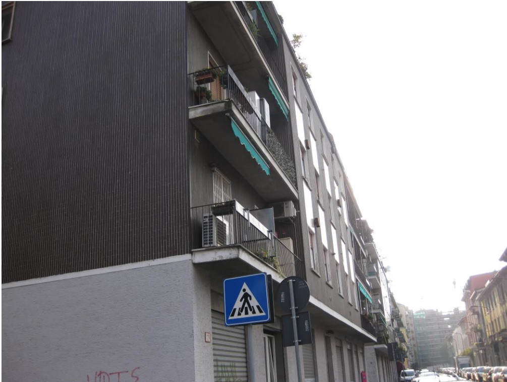
Ulteriore vista dell'immobile da via Melchiorre Delfico (vista da nord).
