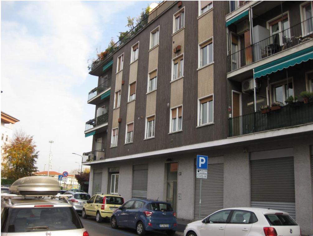
Vista dell'immobile da via Melchiorre Delfico.
