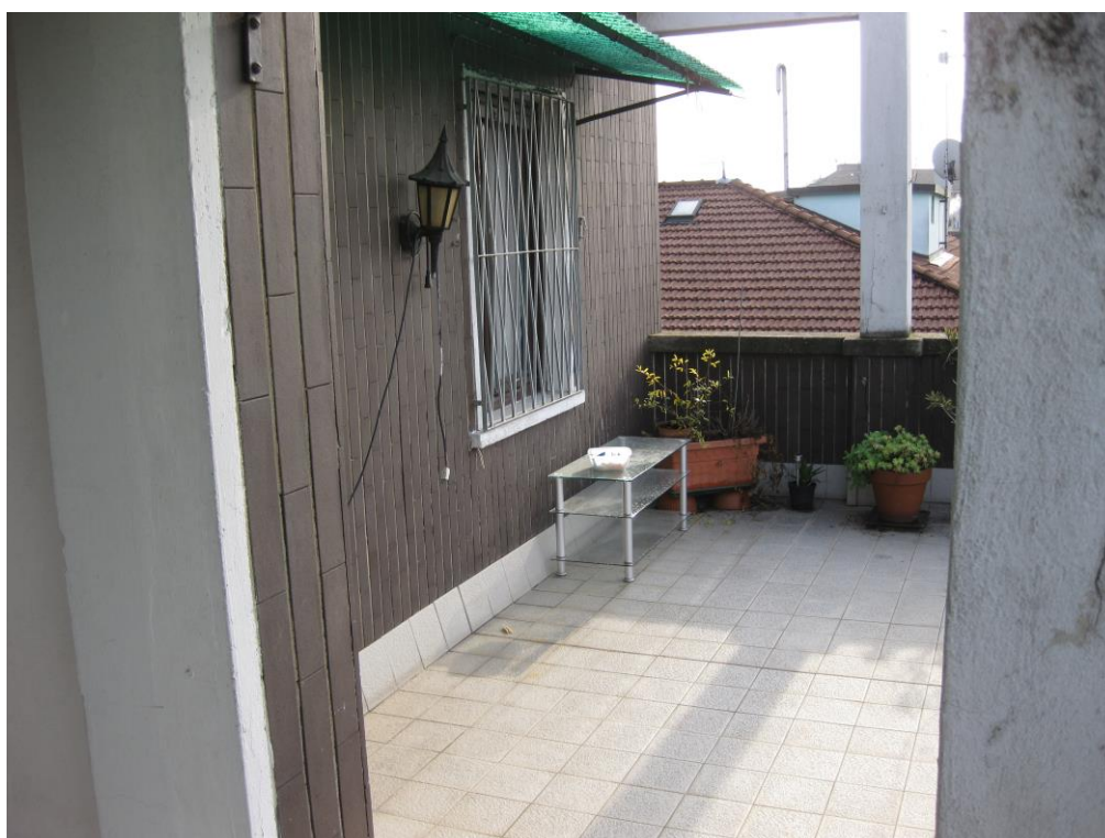
Vista del terrazzo condominiale su cui affaccia l'appartamento oggetto di stima.
