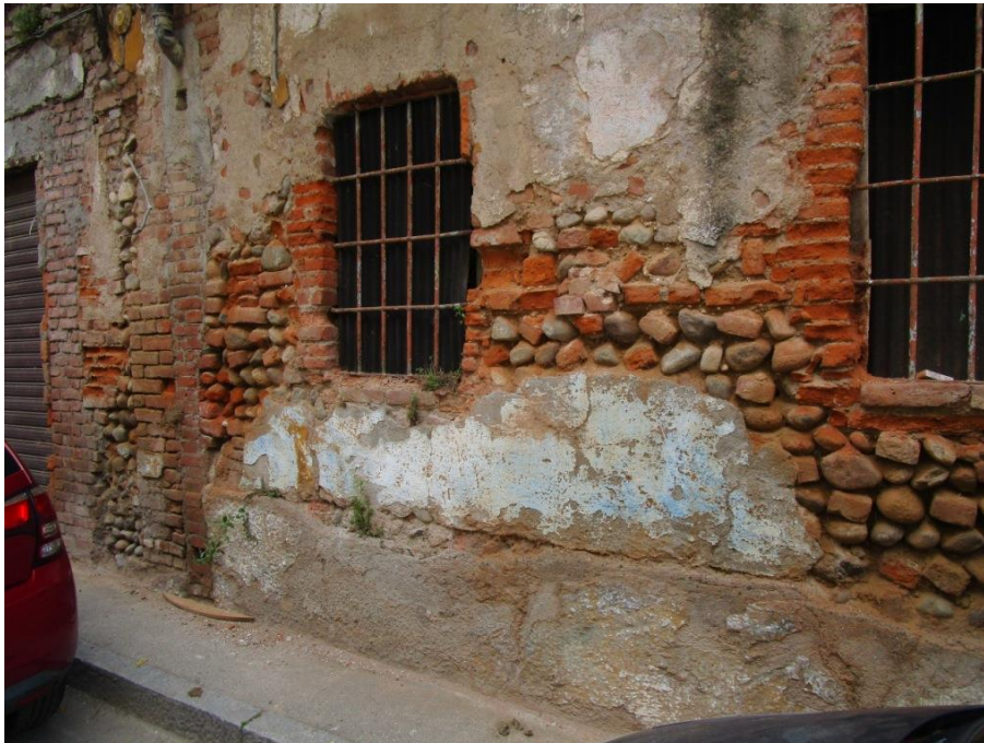
Vista di dettaglio della muratura di confine, con affaccio su via Gorizia
