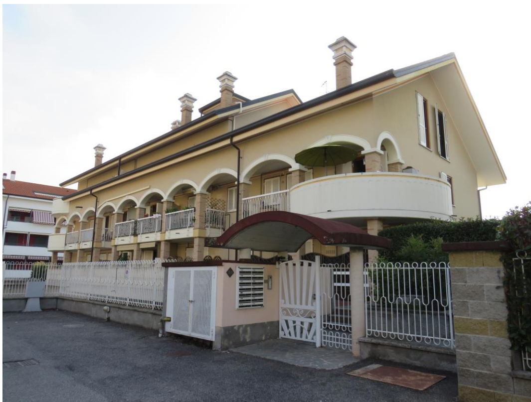
FACCIATA SU CORSELLO INTERNO
