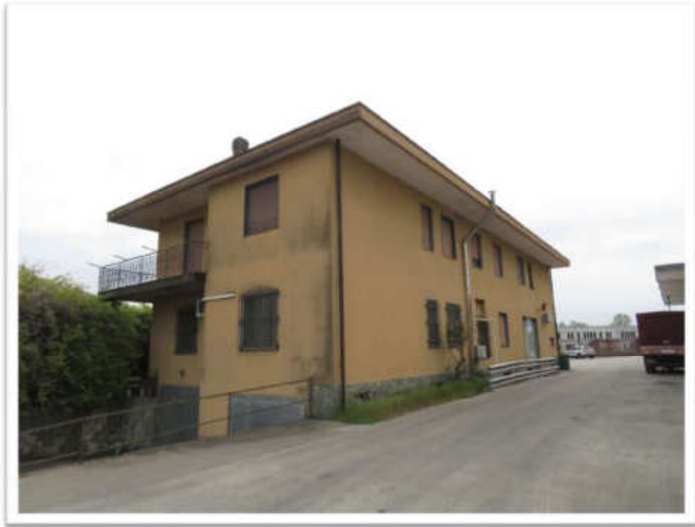
Vista accidentale del fabbricato e vista Nord.
