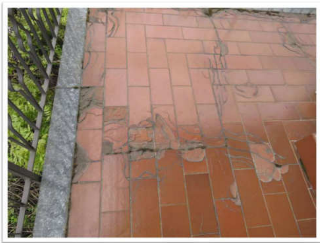
Balcone (si notino i cavi dell'elettrodotto molto vicini) e particolare del degrado della pavimentazione del balcone.
