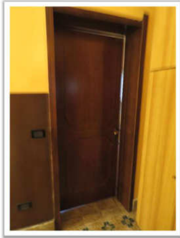
Viste della zona d'ingresso dell'alloggio in esame – Sub. 8 – al piano primo.
