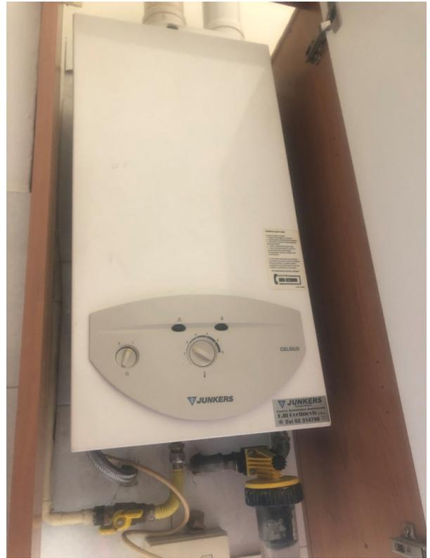
*Tipologia caloriferi e caldaia (per prod. acqua calda sanitaria)*
